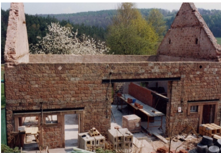
Umbau der Scheune 1991...
