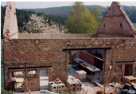
Umbau der Scheune 1991...
