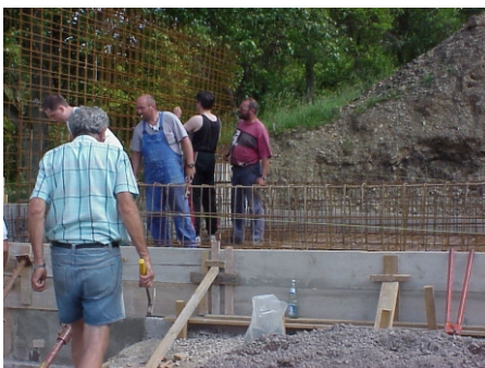
Arbeitseinsatz, offene Schießanlage SV-Etschberg
