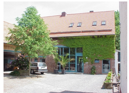
...zum heutigen Bürogebäude
